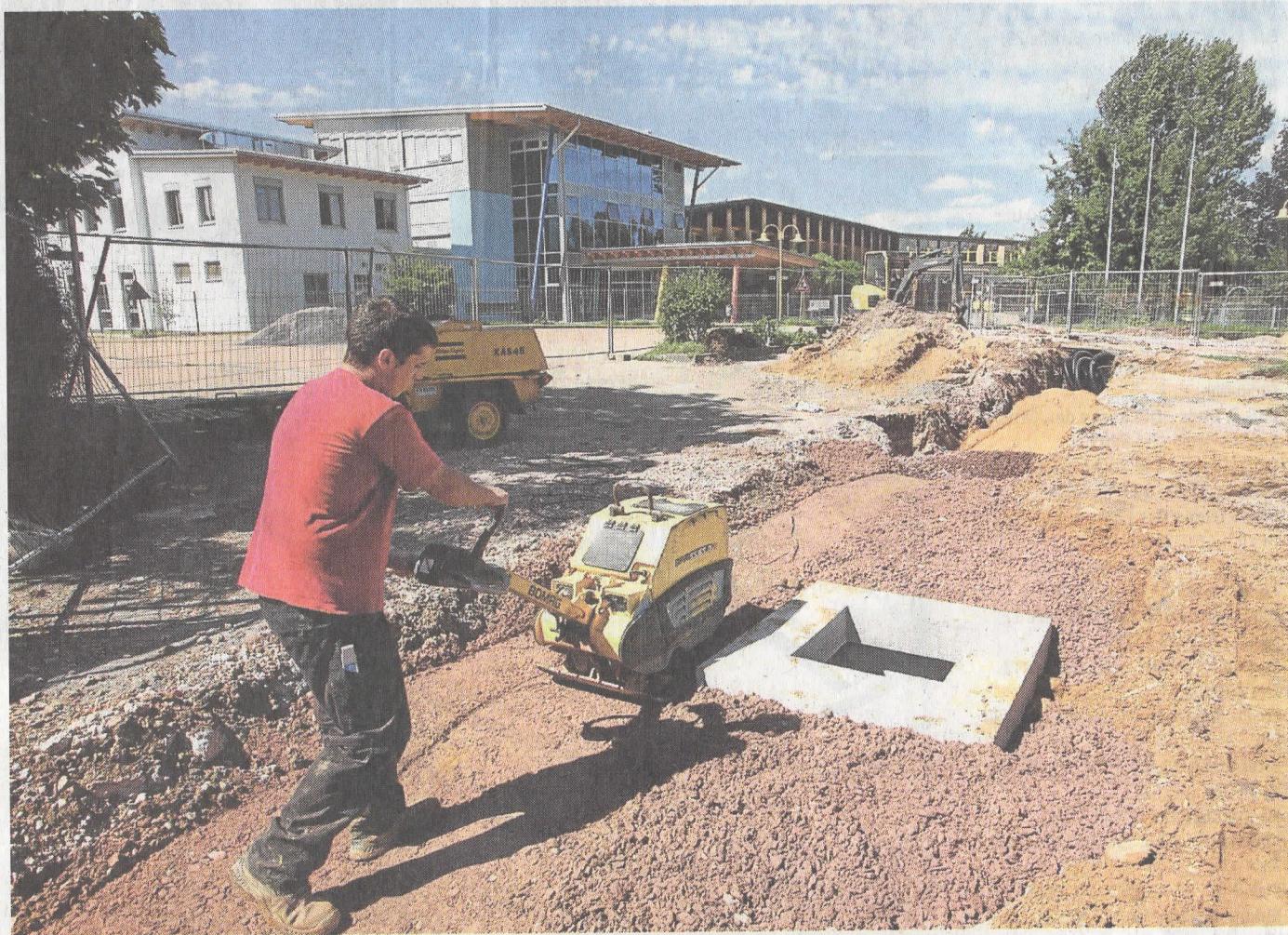
Die Versorgungsleitungen sind verlegt, noch im Herbst sollen die Arbeiten für den Neubau starten.
